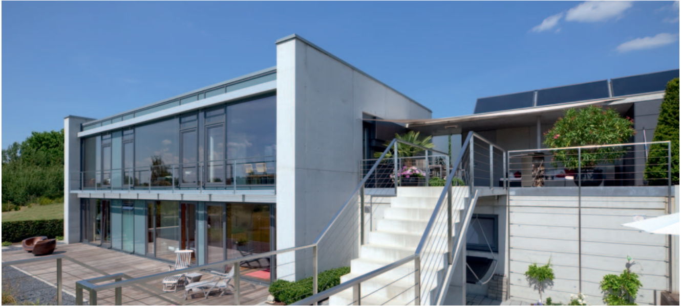
Montage sur toit plat
