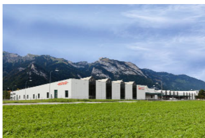
Producción de sistemas de calefacción en Sennwald - Suiza
